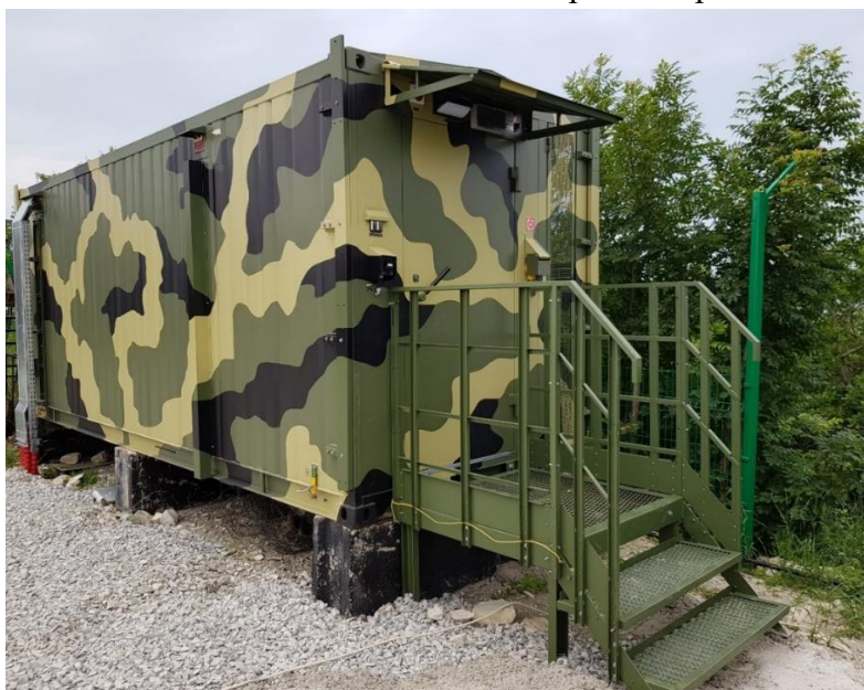
Рис.1. Узел связи контейнерного типа разработки АО «ОНИИП»
